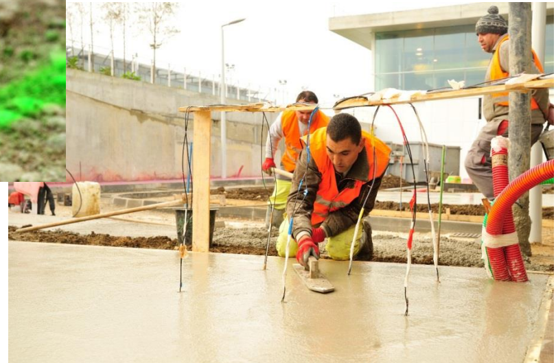
Coulage du béton
