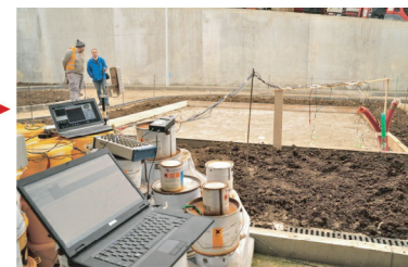
Installation des capteurs noyés dans Sense-City
