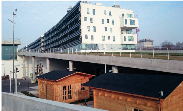
Vue d'ensemble de l'instrumentation déployée sur site
