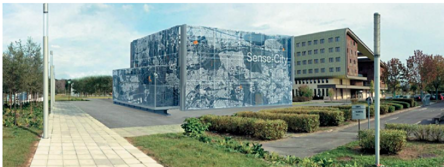
Vue de la future chambre climatique
